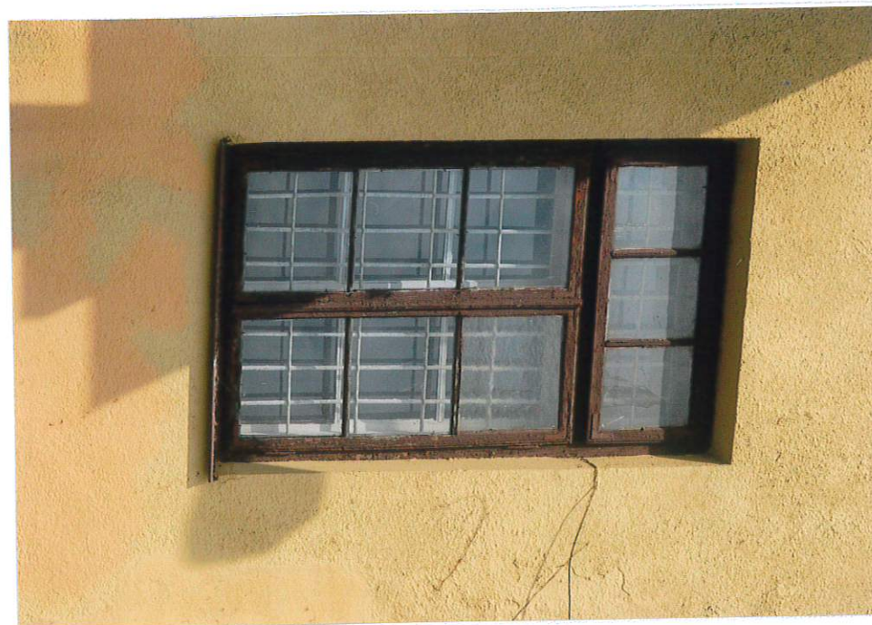
Fot. 6. Elewacja frontowa (południowa), parter – pierwotne okno ościeżnicowe, 2019.
