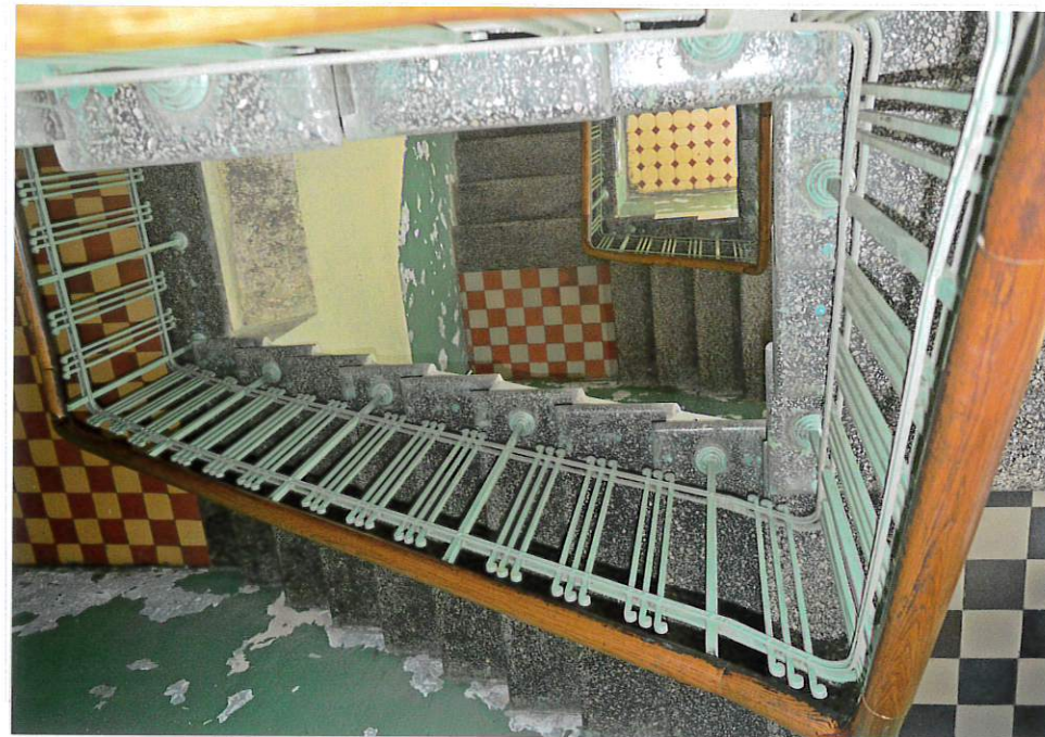
Fot. 13. Klatka schodowa, 2019.
